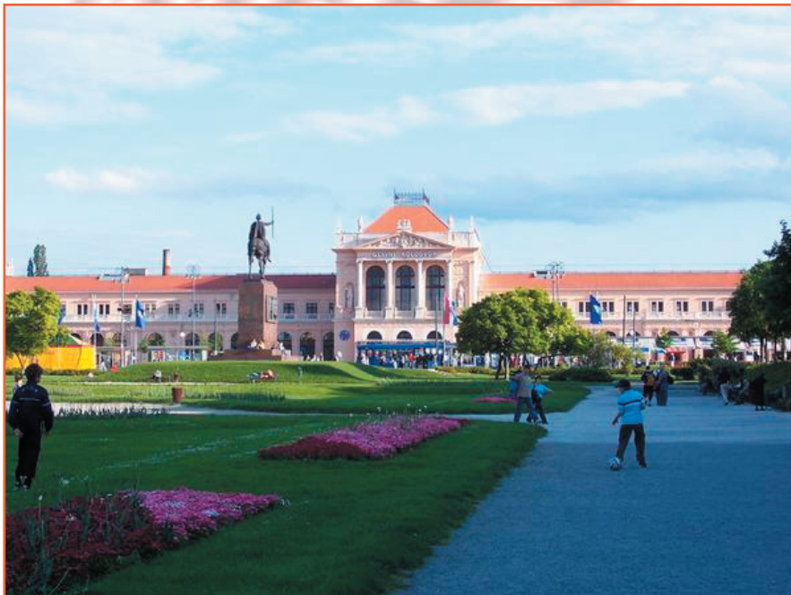
Estacion Central. Zagreb, Croacia
